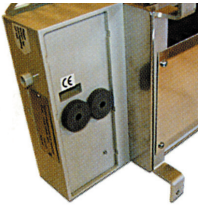
背面右側ケーブル導入口
